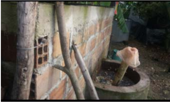
Salida y mezcla de los excrementos de los cerdos o la materia orgánica base para la producción del biogás y el biofertilizante.
