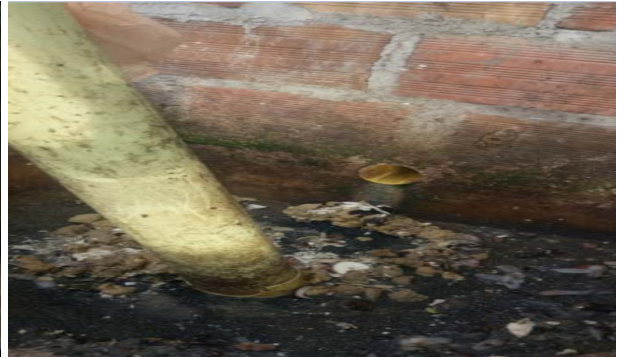
Salida y mezcla de los excrementos de los cerdos o la materia orgánica base para la producción del biogás y el biofertilizante.
