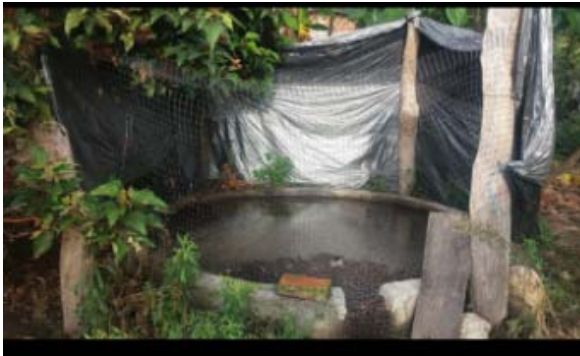
Reactor o Contenedor cerrado, hermético e impermeable donde se deposita y se realiza la digestión de la materia orgánica excretada por los cerdos, así como los frutos recolectados y no comercializados por el campesino.
