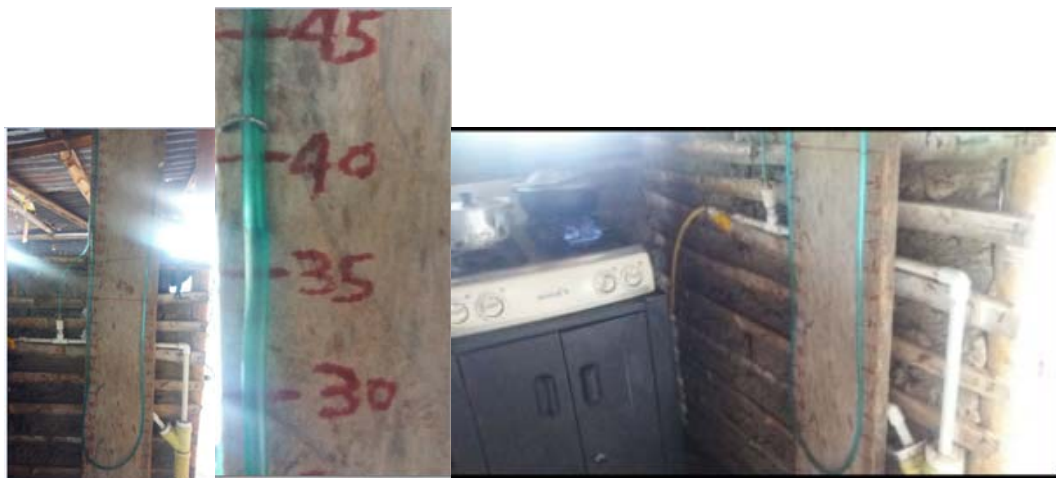
Ingreso del biogás o Gas Metano a la estufa - Tabla medidora de la presión del gas-
